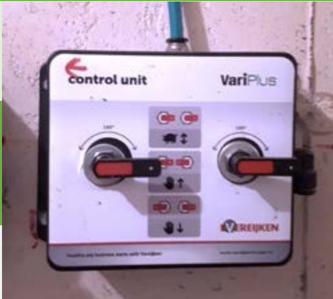
Contrôle des cases ascenseurs
